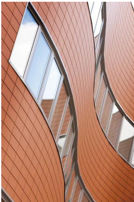
5.3.7. ábra: „Hullámos“ fal illusztrációja szálcement burkolólapokkal burkolva, forrás: Equitone
