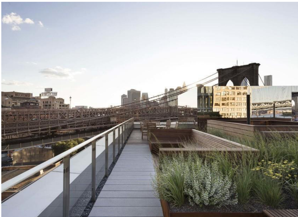
5.4.5. ábra: „Zöld“ lapostetőt bemutató fotó, amely közösségi célt szolgál, Brooklyn-i példa, New York, Egyesült Államok „Dock Street Rooftop Terrace“
